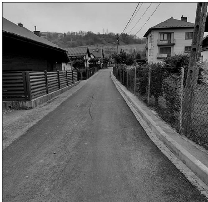
Zmodernizowana droga na osiedlu Malce-Majerany w Mszanie Górnej
