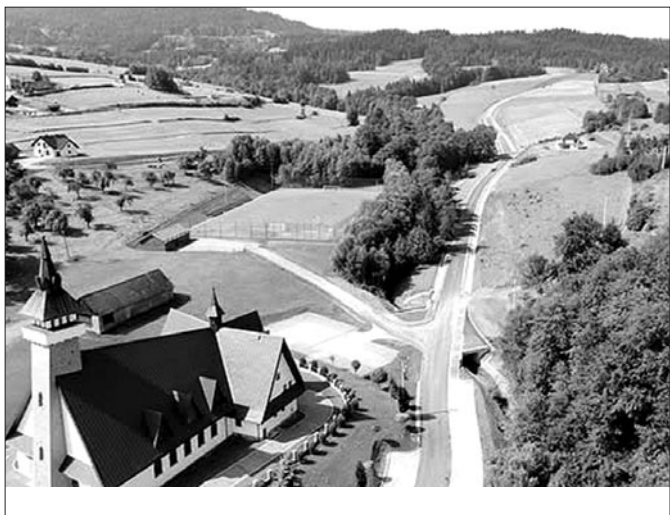
Zmodernizowana droga do os. Zarębki w Olszówce
