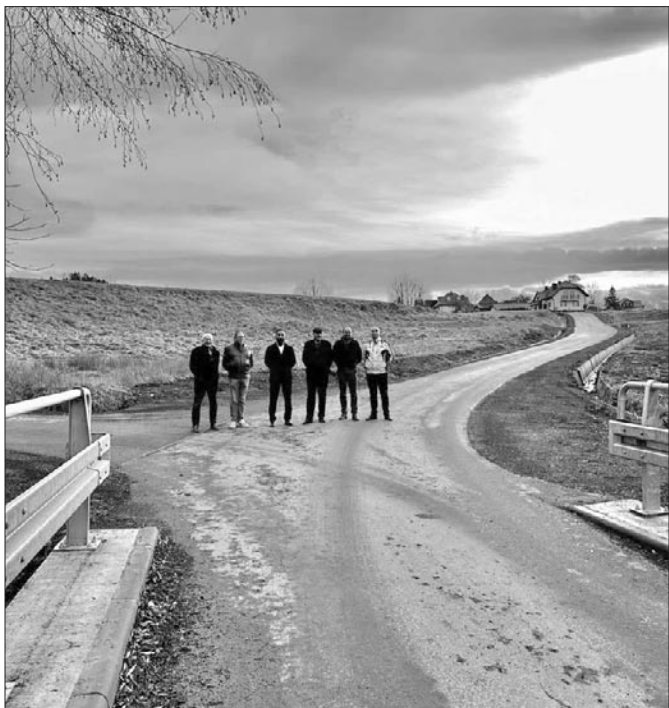
Odbiór zmodernizowanej drogi Nowa Wieś w Łętowem
