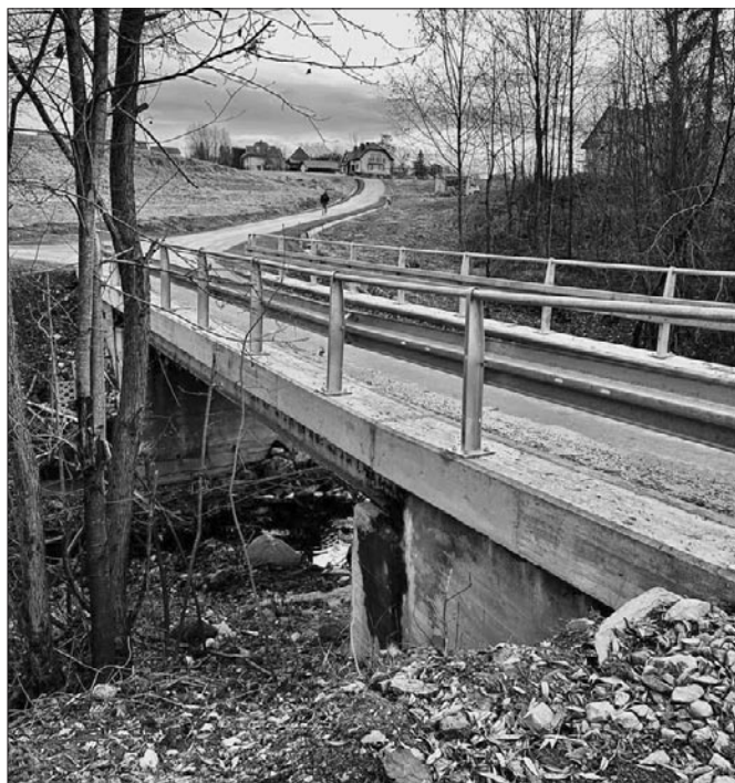
Wyremontowana droga Nowa Wieś w Łętowie
