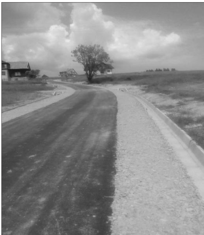
Droga na osiedlu WYDRY w Łętowie
