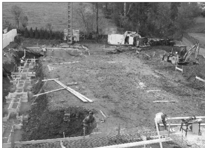
Budowa sali gimnastycznej przy SP2 w Mszanie Górnej
