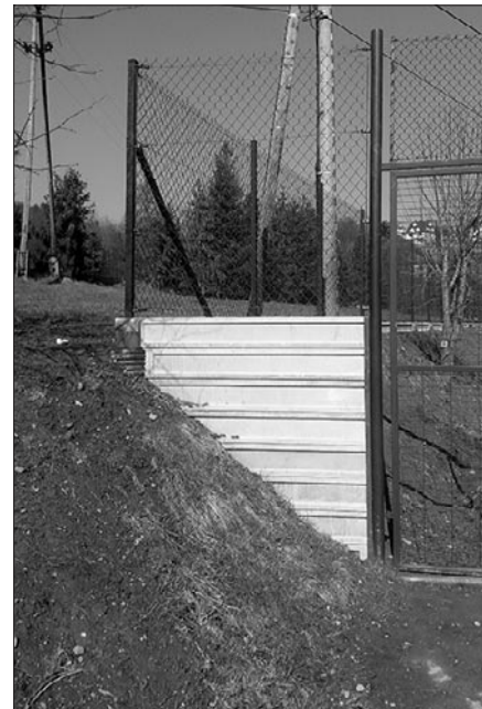
Glisne – ogrodzenie obiektu sportowego
