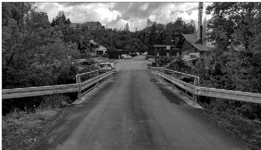
Wyremontowany most w ciągu drogi do osiedla Wadyłe w Mszanie Górnej
