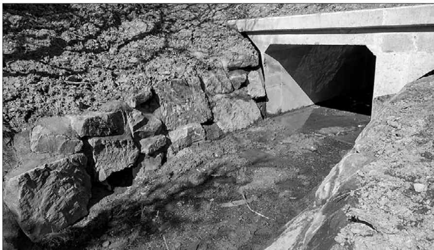
Przepust Sukówka w Kasinie Wielkiej
